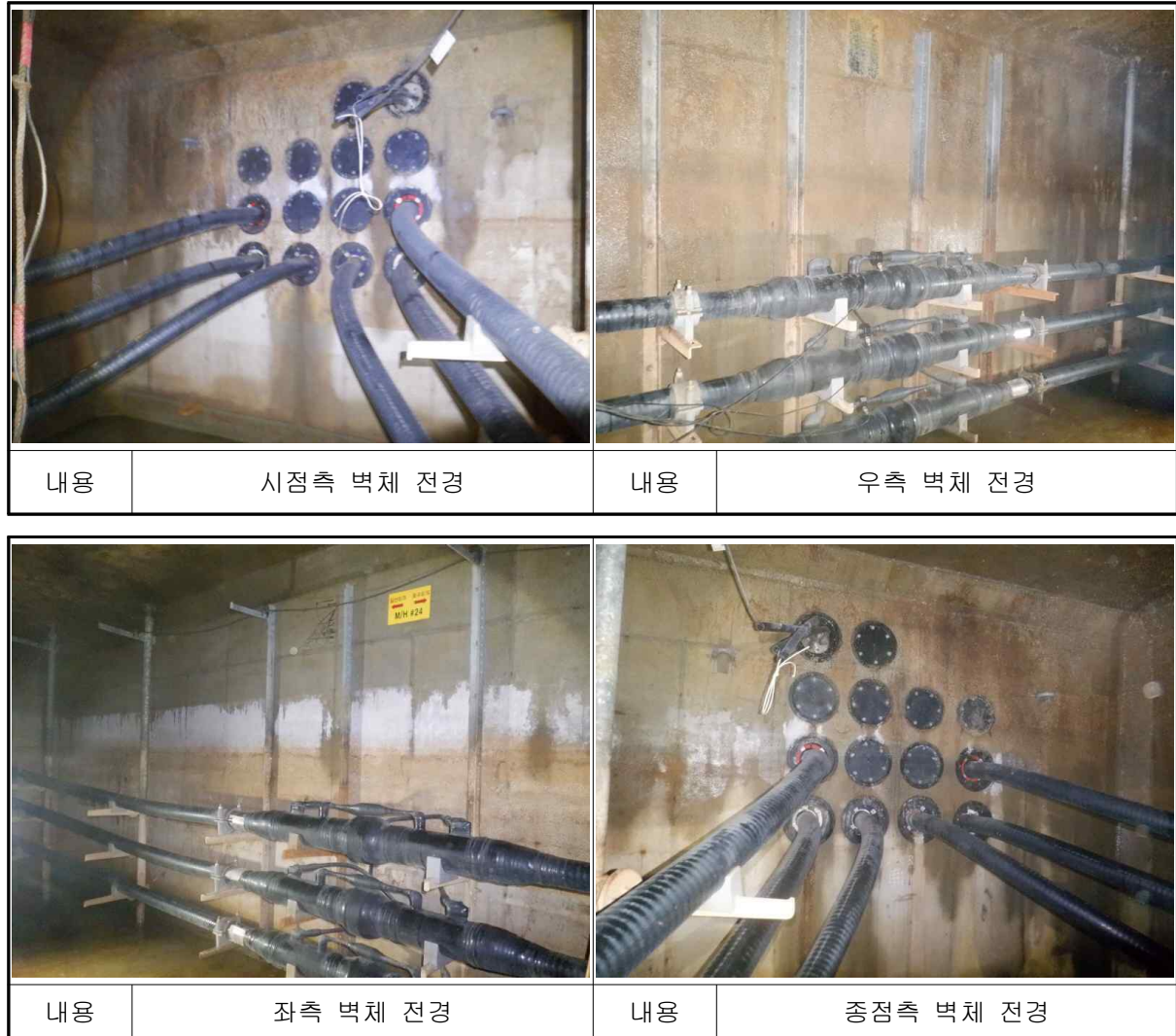
[사진 8.33] 일산~호수#24 전경
