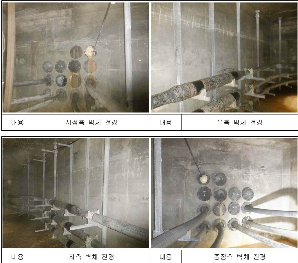
[사진 8.9] 일산~호수#18 전경
