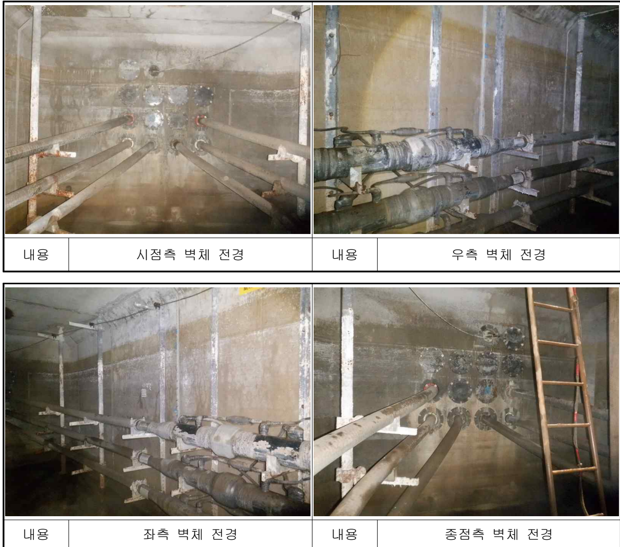
[사진 8.41] 일산~호수#26 전경
