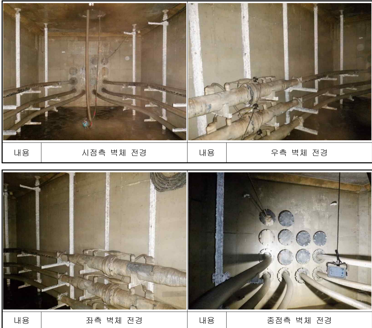
[사진 8.17] 일산~호수#20 전경
